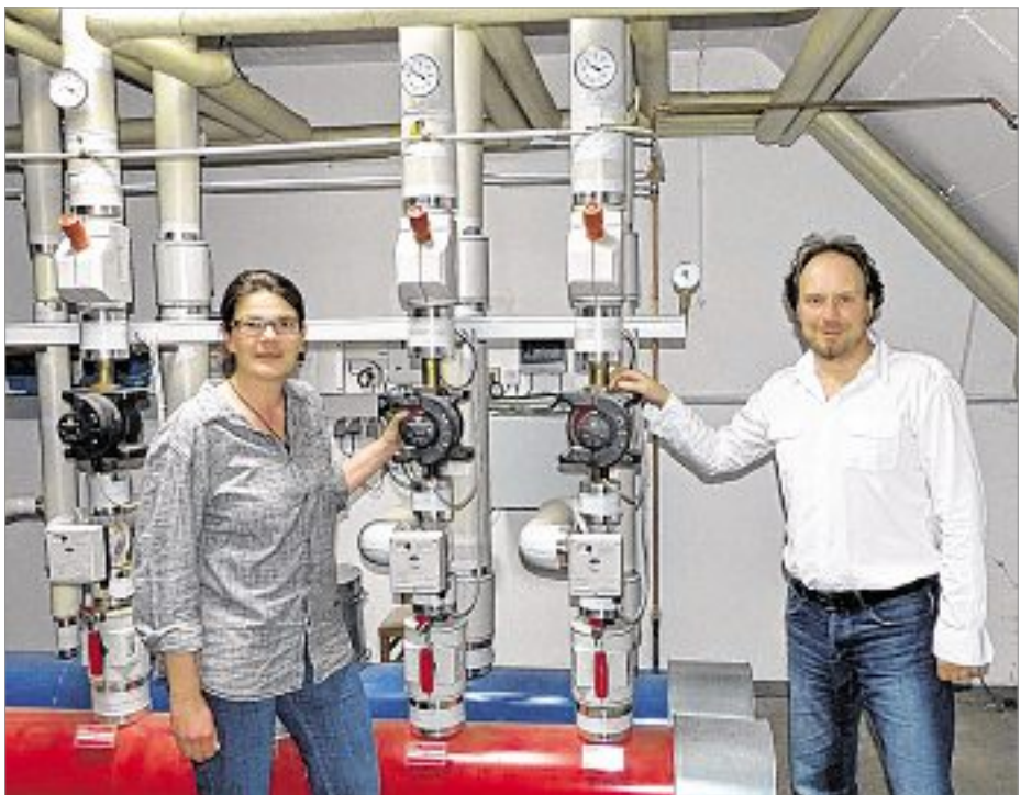
Aus Kostengründen und für den Klimaschutz setzen Birgit Frerig-Liekhues und Oliver Fischer im Rathaus auf effiziente Heizungspumpen. Foto: Stadt
